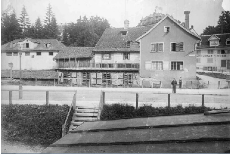
Vor 1893. Lämmli brunnenstr. 49 mit Verbindungstreppe zum tiefer gelegenen Sägegässlein im Vordergrund. Im Hintergrund rechts Wasch-Anstalt Fl. Seifert und dahinter die Rorschacherstraße.
