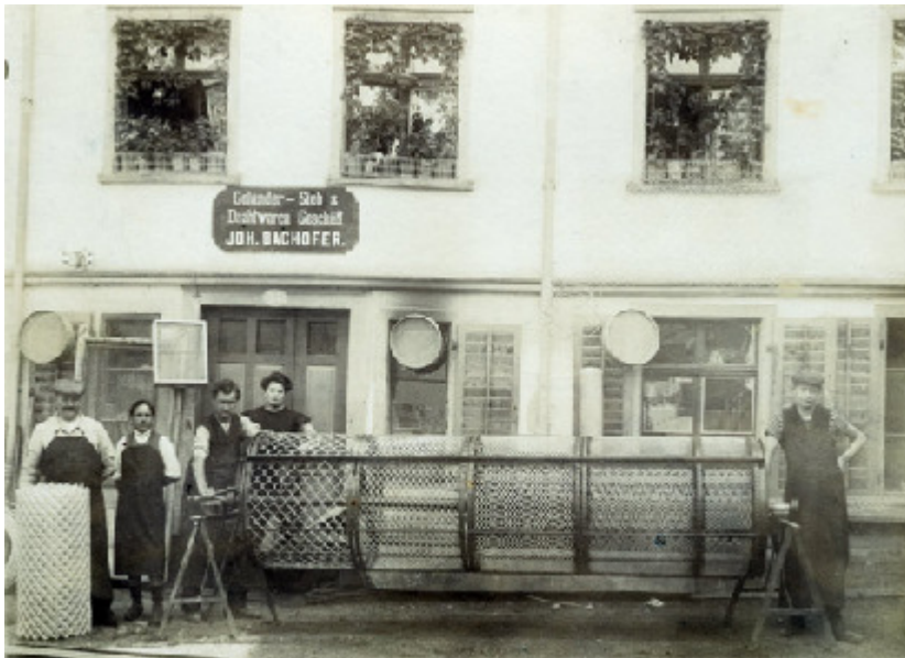
O. J. Detailansicht von Lämmlisbrunnenstr. 24, Drahtwaren Joh. Bachofer.
