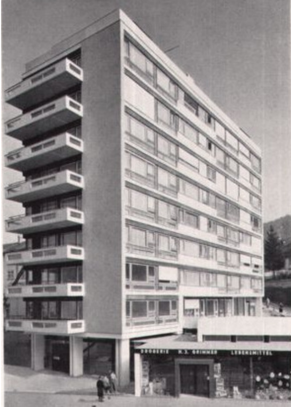
1959. Detailaufnahme von Lämmli brunnenstr. 44.
